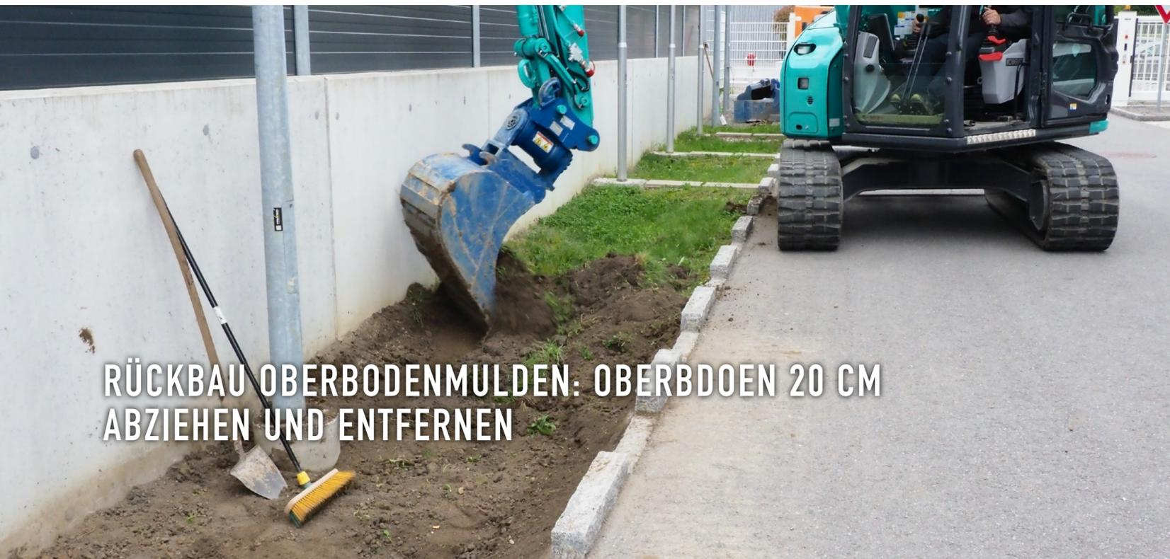
RÜCKBAU OBERBODENMULDEN: OBERBODEN 20 CM ABZIEHEN UND ENTFERNEN
