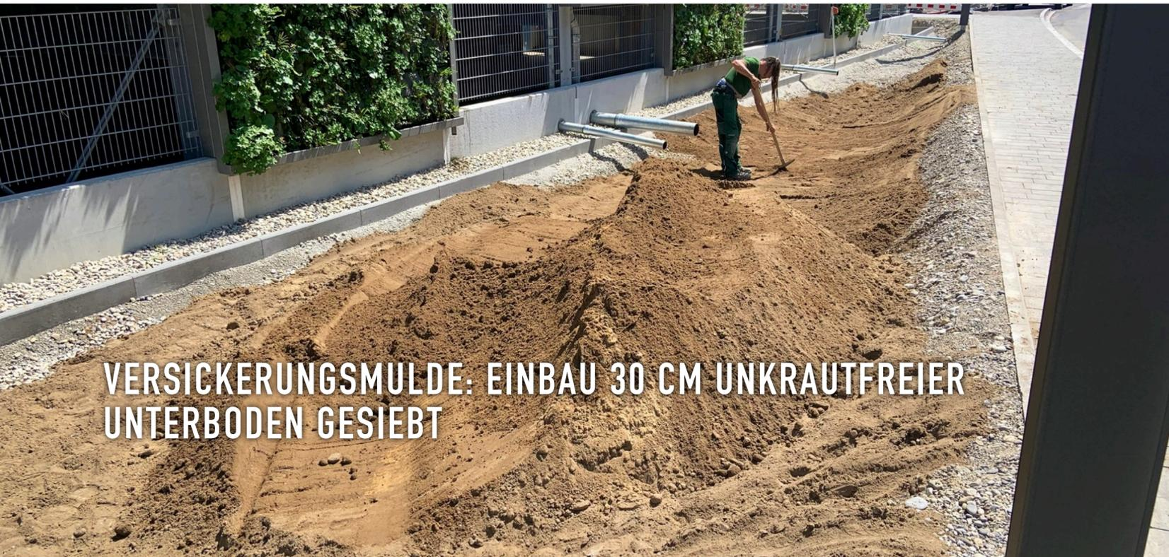
VERSICKERUNGSMULDE: EINBAU 30 CM UNKRAUTFREIER UNTERBODEN GESIEBT
