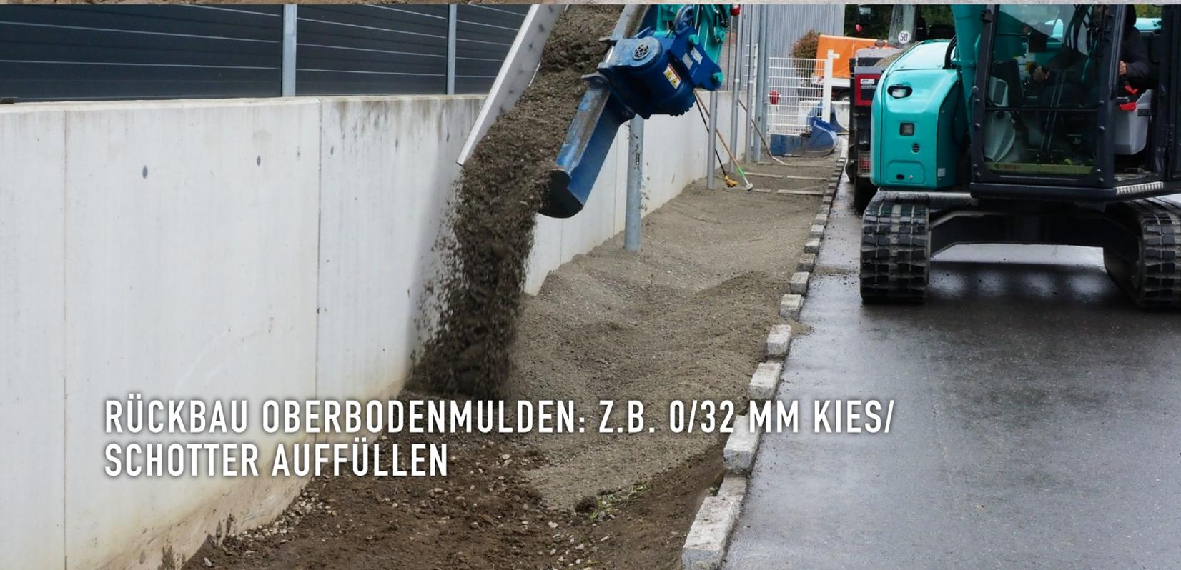
RÜCKBAU OBERBODENMULDEN: Z.B. 0/32-MM KIES/SCHOTTER AUFFÜLLEN
