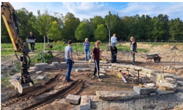
Erste Mitmachbaustelle – 24.09.22 - Foto S. Meier
